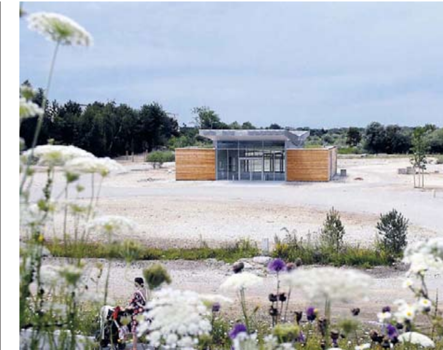
Eine kleine Insel im großen Heide-Biotop ist das Heidehaus, das in den vergangenen Monaten unweit der U-Bahn-Haltestelle Fröttmaning errichtet wurde. Foto: Renate Schmidt
