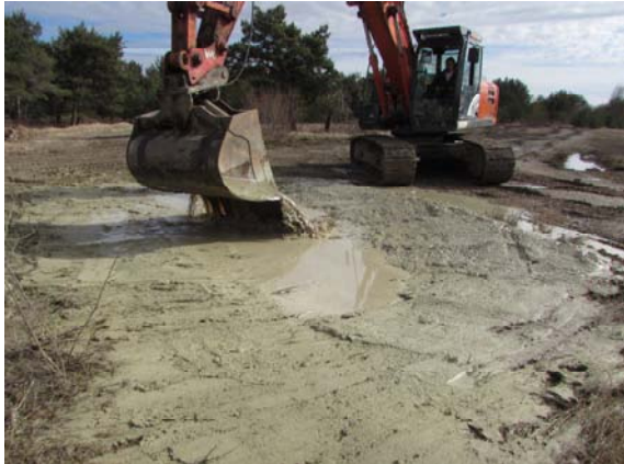
Baggararbeiten am Tümpel auf AF 12
