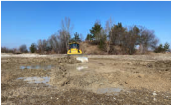
Tümpelbefahrung und Modellierung mit Schubraupe (Quelle: HFV) Modellierte Senke nach Abschluss der Arbeiten (Quelle: HFV)
